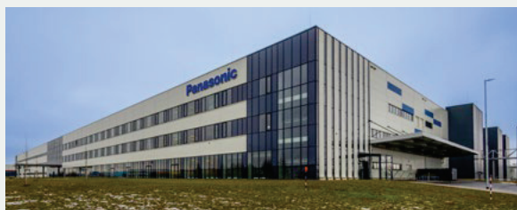
Fabryka pomp ciepła powietrze-woda Panasonic Pilzno, Republika Czeska VRF, jednostki dachowe i chillery
